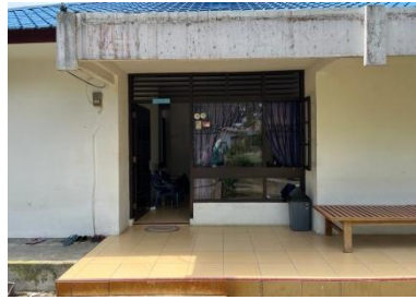
Gambar 3. Akses ke pintu depan tanpa ramp dan pegangan dinding (Dokumentasi Penulis, 2023)
