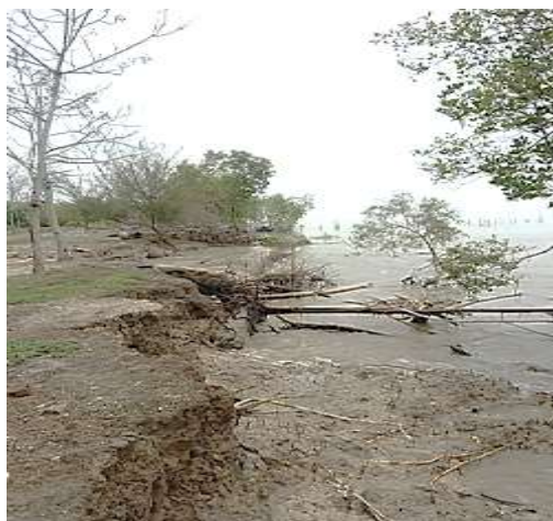
Gambar 4 Kerusakan Mangrove Akibat Abrasi Pantai
